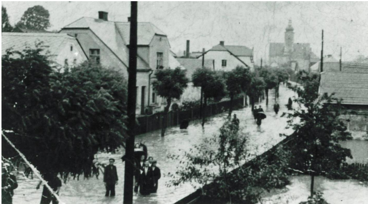
Obr. Dobová fotografie z povodně v roce 1939 (zdroj: obecní úřad Píšť).
