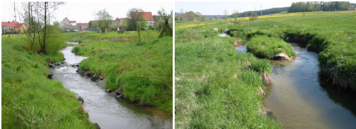
Obr. Revitalizace potoka Zusam u obce Obergessertshausen, Bavorsko. Může se jednat o jednoduchá opatření typu kamenného skluzu až po celkové rozvolnění koryta. Na fotografii vpravo je vytvořena snížená a častěji přeplavovaná lavice v korytě.
